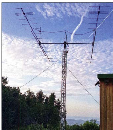
Die zwei 14-Element-Yagi-Antennen nach DK7ZB am Standort von Tom, SV8PEX, etwa 550 m hoch auf Korfu; das gute Take-off übers Meer war sicher auch hilfreich.
