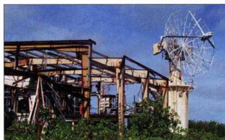
Ruinen einer ehemaligen Satellitenstation der Amerikaner
