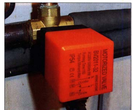
Bild 10: Mit einem Mehrwegeventil ist der Heizkreislauf von der App aus zwischen Heizen und Kühlen umschaltbar.
