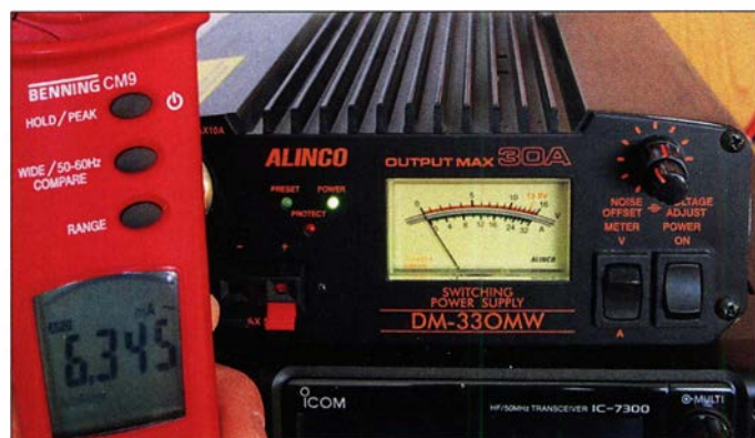
Bild 4: Messung des Fehlerstroms im PE-Leiter an einem Alinco-Schaltnetzteil; das eingebaute EMV-Filter verursacht 6,3 mA, ohne dass ein Fehler vorliegt.
