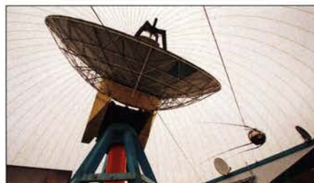
QO-100-Satellitenbodenstation, Radom der Sternwarte Bochum Foto: IUZ
